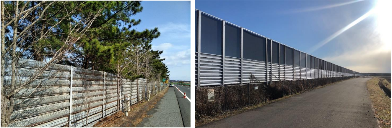
■令和5年度優秀工事として表彰された防雪柵工事（東北自動車道）_左：施工前の防雪柵（3m）、右：施工後の防雪柵（4m）
