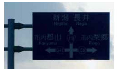
電気を使わず、手で最大4つの表示に切り替えられる四可変標識
