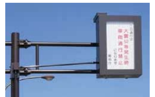
電気を使わず、手で最大4つの表示に切り替えられる四可変標識
