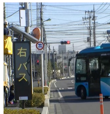
■ICT LED 電光掲示板設置の様子 (埼玉県内)
