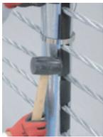
プラスチックハンマーで間隔材(4箇所×両面)の位置をセンター(縦並び)に合わせる。
