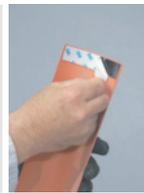
カバー内側の両面テープの剥離紙を剥がし(3箇所ずつ)、センター線に合わせて支柱に押し付ける(両面)。
