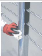
脱脂材とウエスで支柱を洗浄・脱脂する。(主にカバー内側の両面テープにあたる部分)
