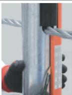
カバーを押し付けて鉛筆などで支柱にセンター線を野書く。(支柱の切り欠きとカバーの溝を合わせる)
