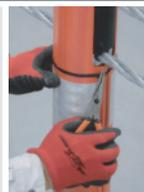
カバーの窪みに合わせ、ラジオペンチで結束バンドを締め付ける(上下2箇所)。
