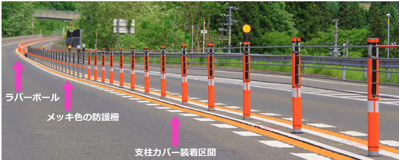
■高速道路のカーブ部分での設置イメージ_支柱カバーの装着により視認性が向上している(前方)
