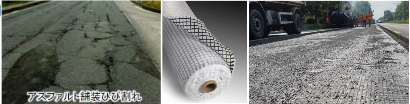
■左：ひび割れ（内閣官房資料より引用）、中央：「グラスグリッド CG100L」、右：「本製品」による道路修繕工事の様子（海外）
